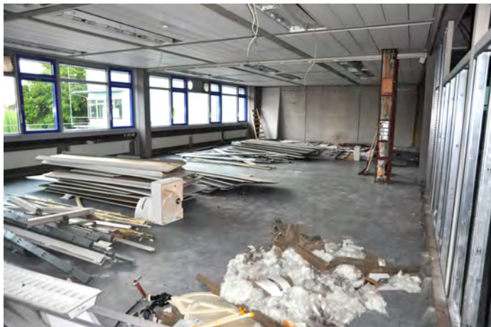
Zustand der Räume A1.04 und A1.05 im Juli 2016
