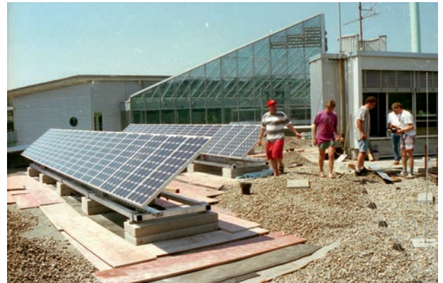
Bau der Solaranlage auf dem Dach der EST
