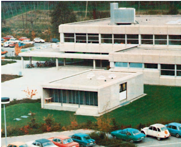
Neubau Oberhofer Straße 25
